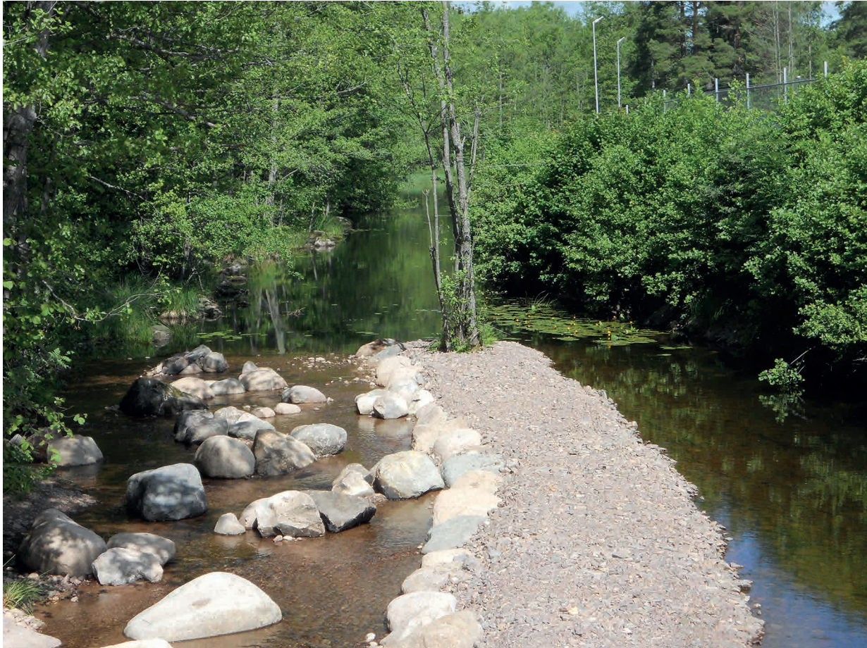
Genomförd åtgärd för fria vandringsvägar i Kisaån, ett omlöp vid Sofidel Swedens anläggning i Kisa.
