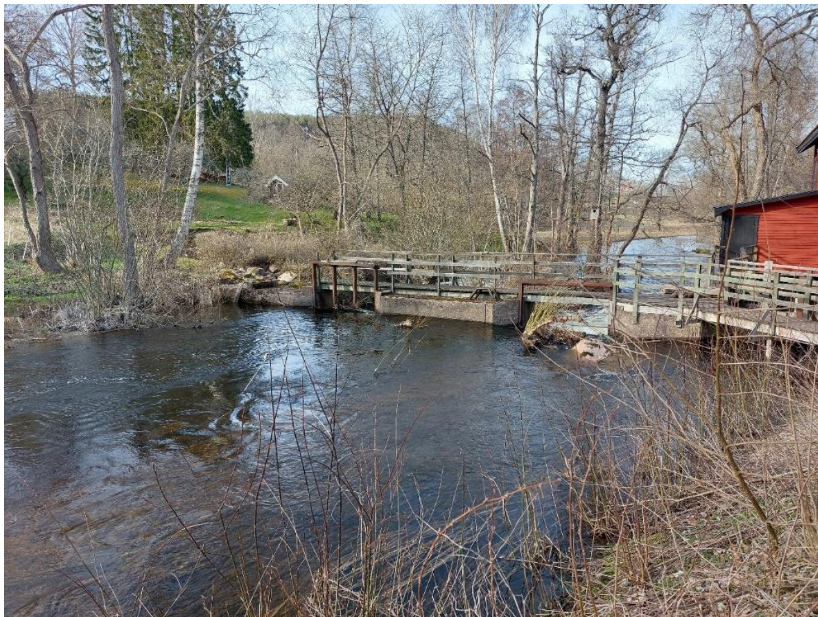
Figur 7. Kölefors Nedre, sedd uppströms ifrån.
