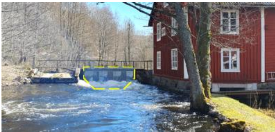
Figur 14. Principiell utformning av en mindre öppning i dammen vid Kölefors Vaddfabrik (sedd nedströms ifrån). Öppningen bedöms bli cirka 5 m bred i botten och ligga cirka 0,6 m under utskovströsklarna.
