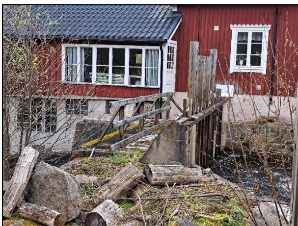
Fig. 20. Delar av dammkroppen och de fyra spettluckorna. Foto taget mot öst. Fig. 21. Spettluckor för att reglera flödet i den östra åfåran. Foto taget mot söder.
