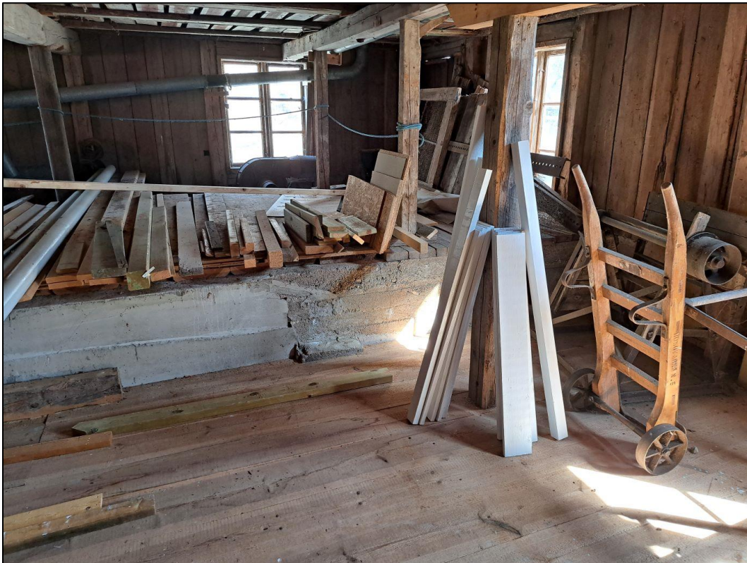
Fig. 106. Nedre plan i fabriken, där bl.a. turbinrännan och golvet renoverades 2004–2005.
