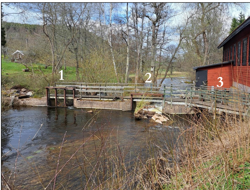
Fig. 85. Dammkroppen. 1. Intaget till garveriet. 2. Öppning till huvudfåran. 3. Intagsrännan till turbinhuset. Nedströms dammkroppen mellan 1 och 2 går en ledarm. Foto taget mot n-ö.
