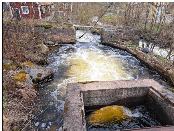
Fig. 33. T.v. Dammkroppen i den västra åfåran, intagsbassängen med två spetluckor. Vattnet rinner idag genom mynningsöppningen till vattentuben. Foto taget mot söder. Fig. 34. T.h. På bilden syns en liten damm som bildats nedanför bassängen. Nedanför dammen syns den äldre skalmursdammen. Foto taget mot norr.
