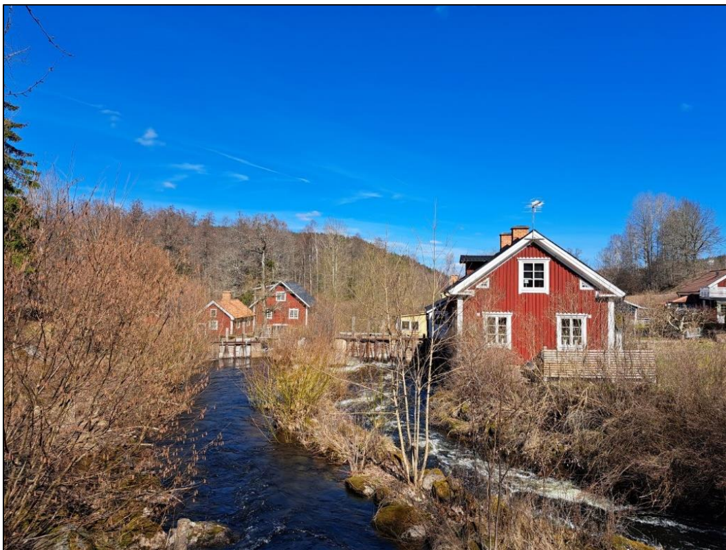
Fig. 25. T.h. i bild syns Södergårdens kvarnbostad. Längre ner t.v. syns Falklyckan. Foto taget mot norr.
