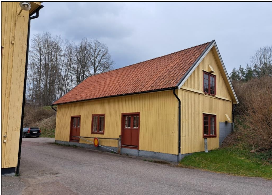
Fig. 74. Verkstad/garage tillhörande fabriksbyggnaden. Foto taget mot n-ö.
