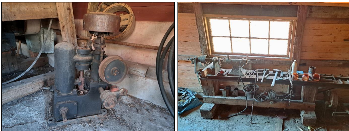
Fig. 83. T.v. En äldre motor. Fig. 84. Verktyg och verktygsbänk i turbinhuset.
