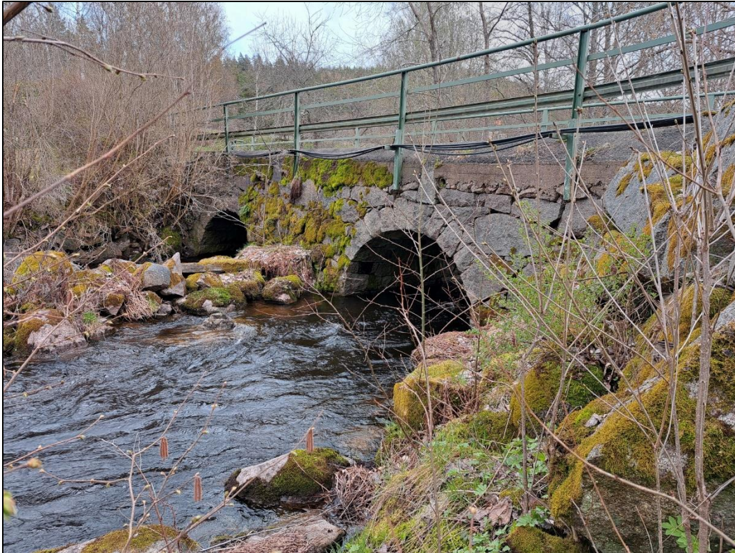
Fig. 10. Stenvälsbro L2011:428. Foto taget mot s-ö.
