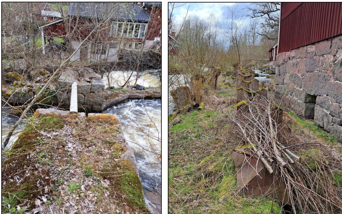
Fig. 39. T.v. Den äldre skalmuren. Foto taget mot s-ö. Fig. 40. Fundamenten till vattentuben. T.h. på bilden syns Falklyckans kvarn.. Foto taget mot söder.
