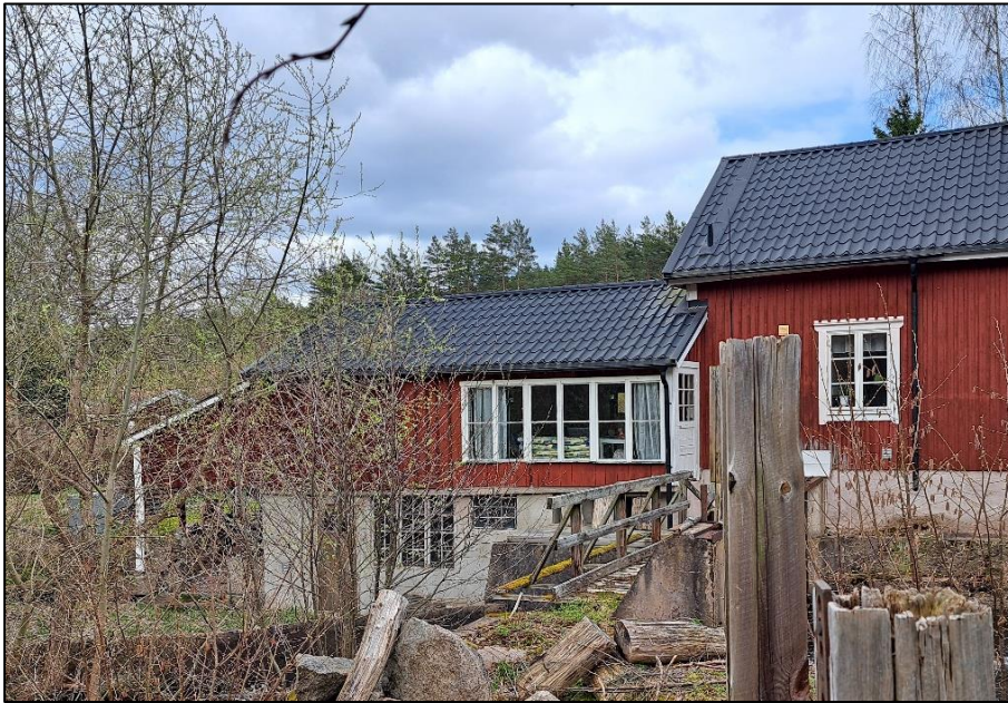
Fig. 22. T.v. är den ombyggda kvarnbyggnaden som sitter ihop med bostadsbuset. Foto taget mot öst.
