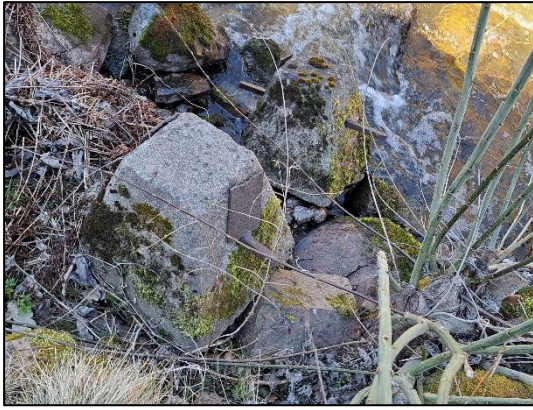
Fig. 73. Fundament vid fabriksbyggnaden efter turbinhuset.
