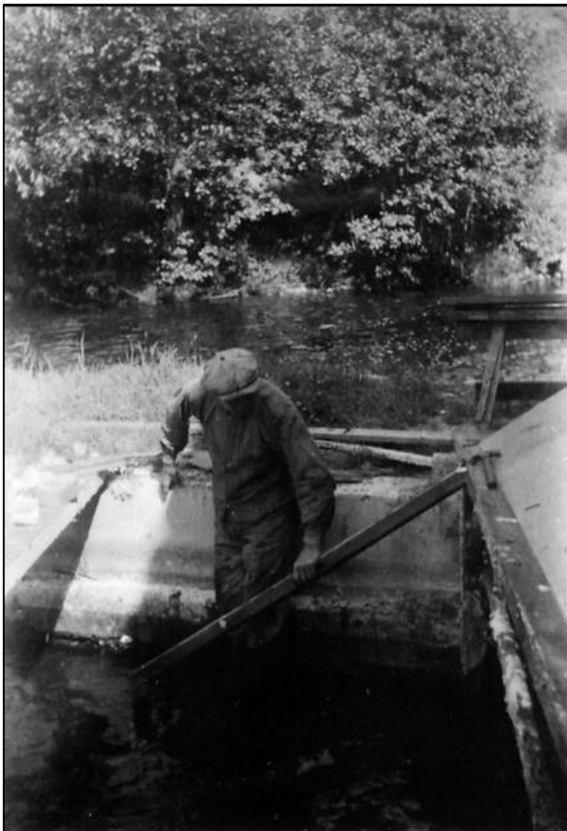
Fig. 102. Historiskt foto från troligen 1940–50-tal när Erik Fransson rensar turbinsumpen. Fotograf okänd. Foto: privat
