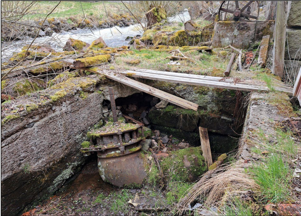
Fig. 41. Turbinsumpen och det som finns kvar efter turbinen. Foto taget mot söder.
