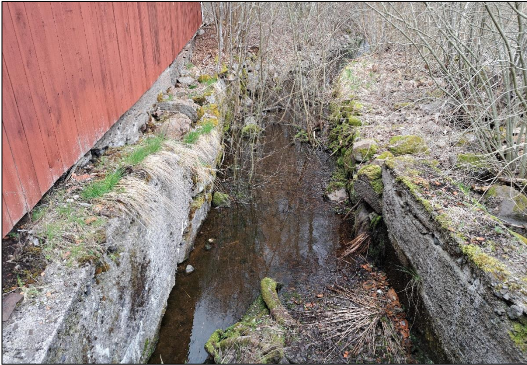
Fig. 43. Närmast kvarnen är utloppsrännan klädd med betong. Foto taget mot norr.
