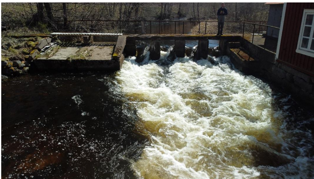
Figur 4. Kölefors Vaddfabrik, sett nedströms ifrån.
