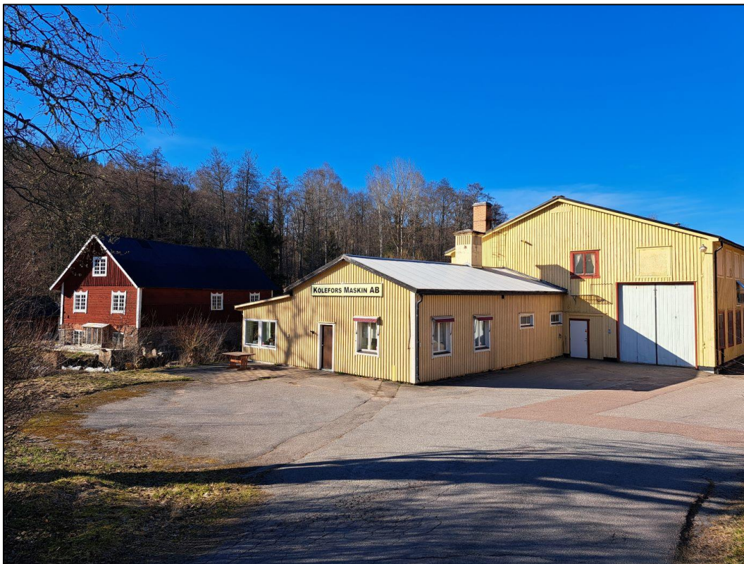
Fig. 70. T.v. på bilden syns Falklyckans kvarn och t.h. i bild är fabriksbyggnaden. Foto taget mot n-v
