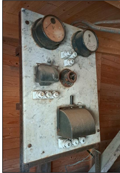
Fig. 79. T.v. Turbinhuset. Foto taget mot n-ö. Fig. 80. T.h. Instrumentpanel på marmorskiva.
