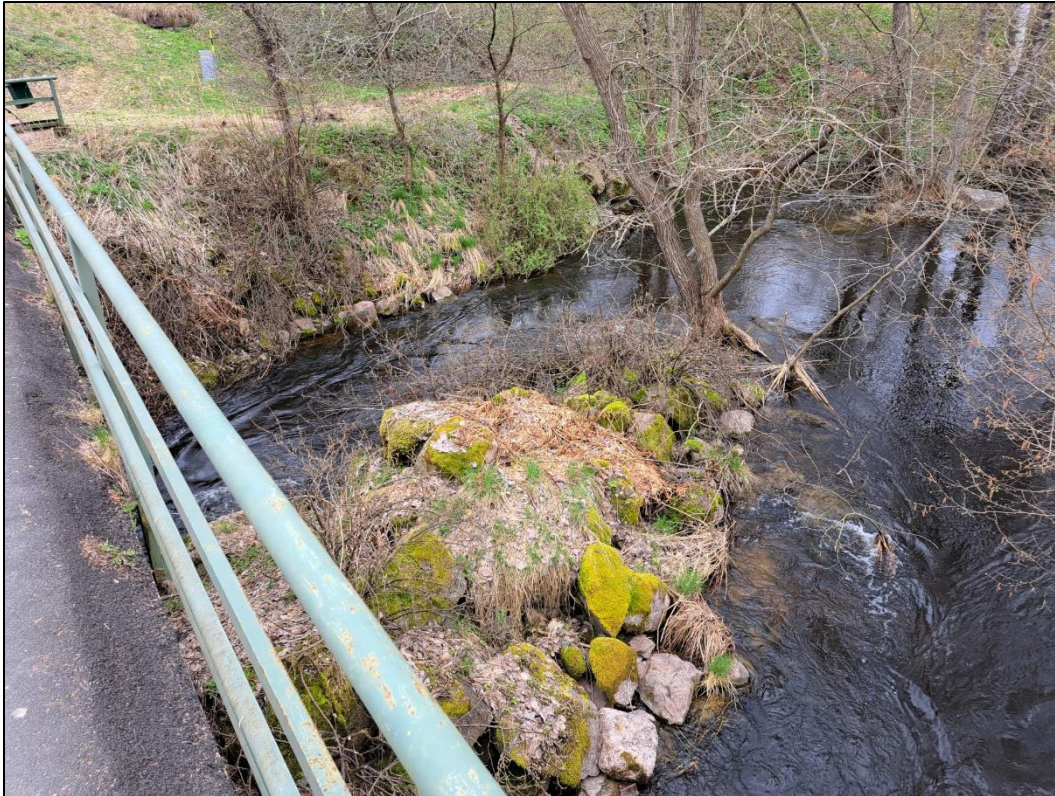
Fig. 12. Vattendelaren/isbrytare vid bro L2011:428. Foto taget mot s-ö.
