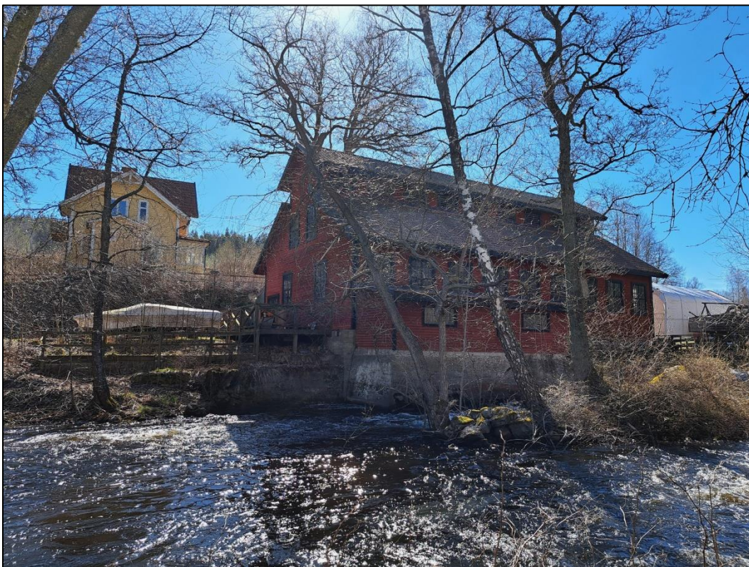
Fig. 78. Liknande vy som bilden ovan. Numera är byggnaden ersatt av en ombyggd smedja och sågen är borta. Foto taget mot väst.
