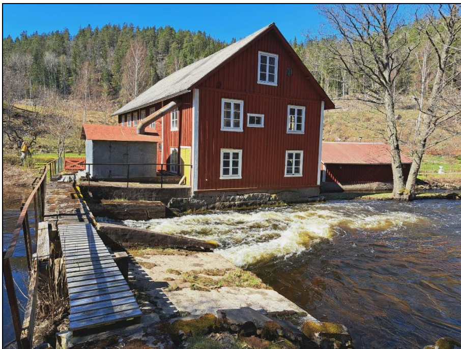
Fig. 119. Visar fabriken östra kortsida, med dammskåpet t.v. i bild. Närmast i bild syns dammbyggnadens bro och skibord. Foto taget mot väst.
