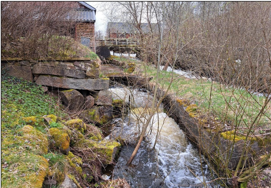
Fig. 27. Utloppsrännan från kvarnen. T.v. i bild syns en stengrund, troligen efter sågen.
