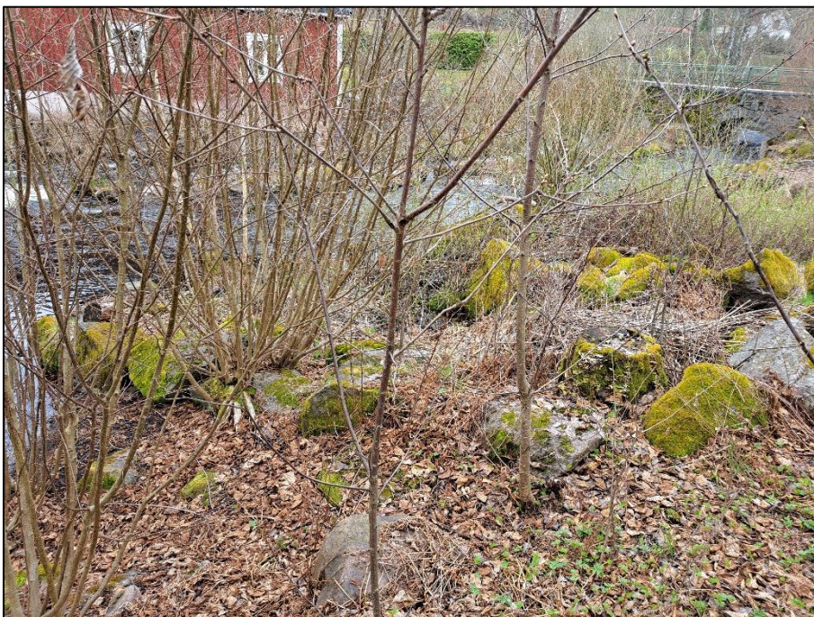
Fig. 37. Stenfundament 2, som ligger strax söder om nuvarande dammkropp. Foto taget mot s-ö.
