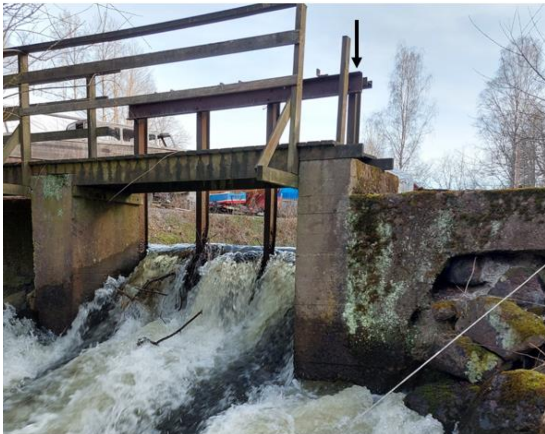
Figur 8. Fixpunktens placering som har nivån +94,25 m i höjdsystem RH2000 vid Kölefors Nedre.
