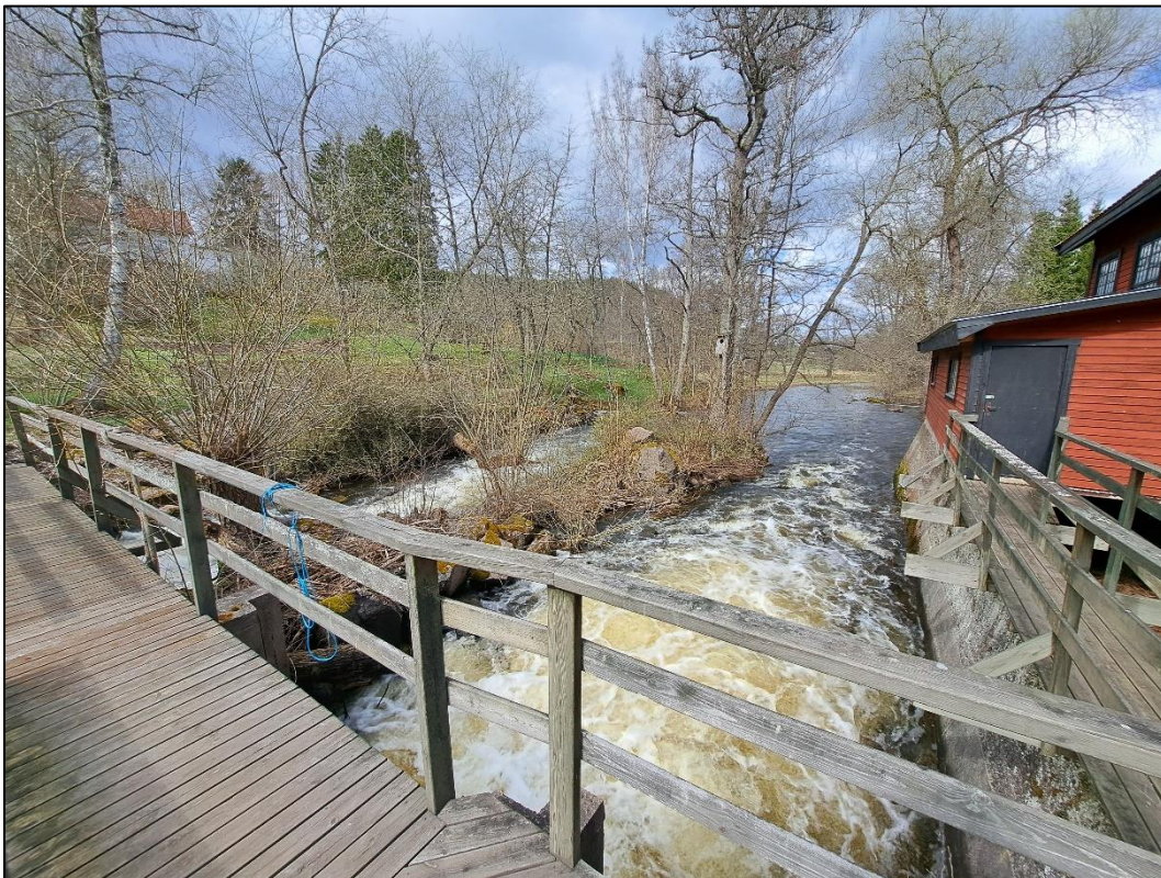
Fig. 88. På dammkroppen finns en bro över ån och en bro ut till turbinhuset t.b. i bild. I mitten syns ledarmen. Foto taget mot norr.
