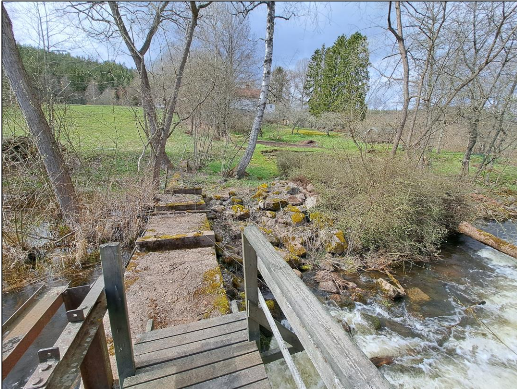
Fig. 87. På den västra sidan av dammkroppen finns ett stenröse med huggen sten. I bakgrunden syns ett vitt boningshus tillhörande Lustbackens. Foto taget mot väst.
