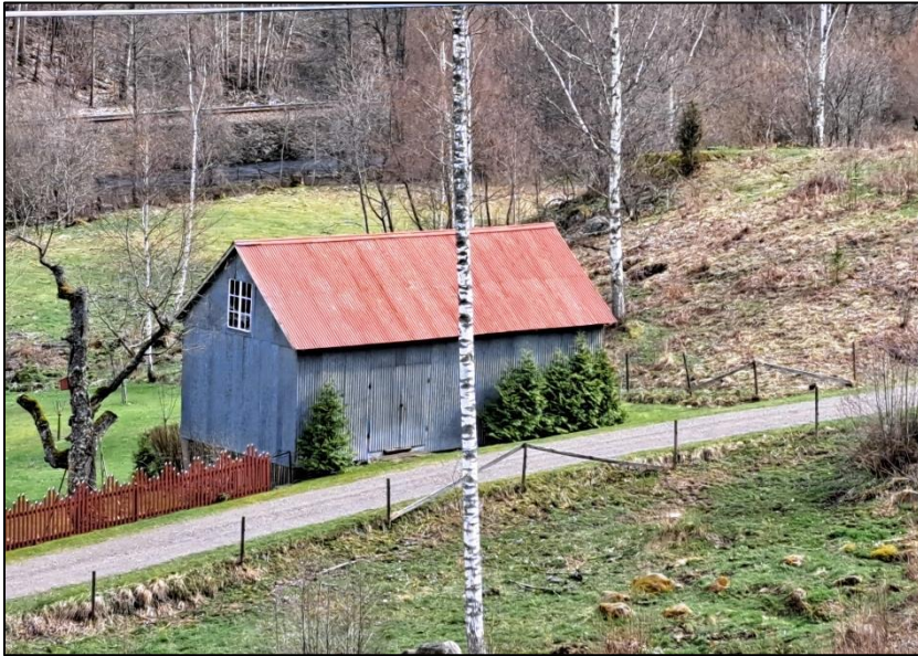
Fig. 125. Plåtmagasinet. Foto taget mot s-ö.
