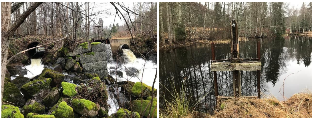
Figur 15. Bilden till vänster visar dammvallen vid Jonsbo med tre utskov. Bilden till höger visar dammluckan i trä. Foto: Annelie Claësson.
