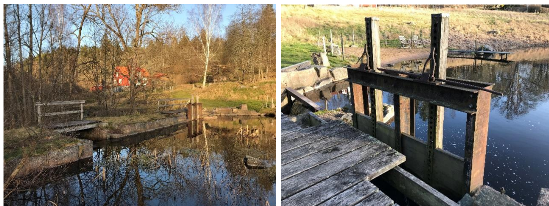
Figur 31. Bilden till vänster visar damm och dammvall vid Hallstad snickerifabrik. Bilden till höger visar en dammlucka i trä i dammvallen. Foto: Annelie Claësson.
