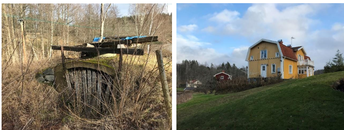
Figur 26. Bilden till vänster visar rest av den valvbro som byggdes för in- och utfart till kvarnen och sågen då trätuben till kraftstationen byggdes (L2021:5428). Bilden till höger visar mjölnarbostaden till Hallstad övre kvarn. Foto: Annelie Claësson.
