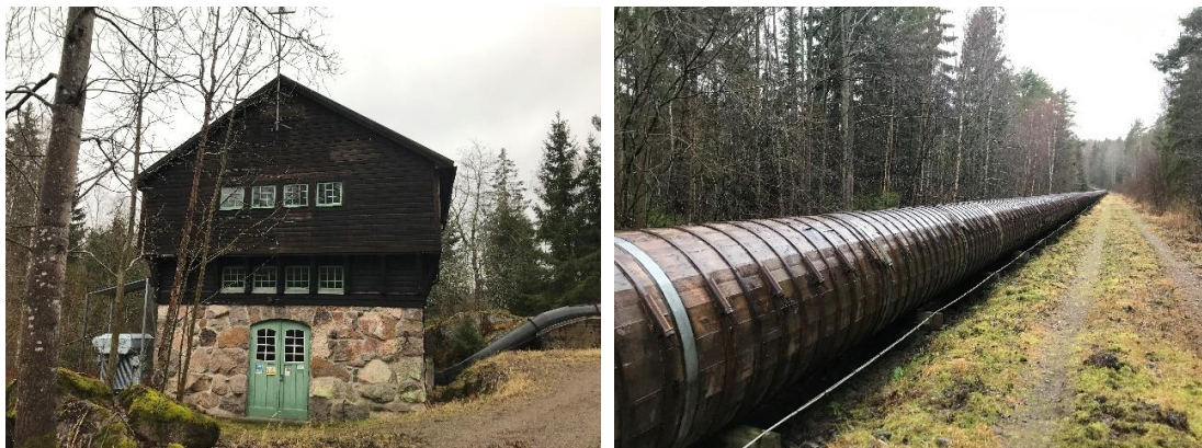
Figur 14. Bilden till höger visar Sjösetter kraftstation. Bilden till vänster visar trätuben som leder vatten från sjön Södra Viggen till kraftstationen. Foto: Annelie Claësson.
